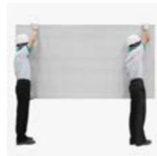
Luôn luôn để tấm đứng khi di chuyển trong quá trình bốc xếp
