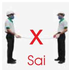
Tấm bị võng khi bốc xếp tấm ở tư thế nằm ngang
