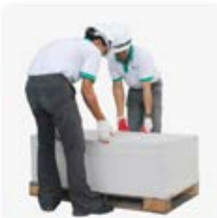
Các tấm DURAflex phải bốc ở giữa bên cạnh tấm
